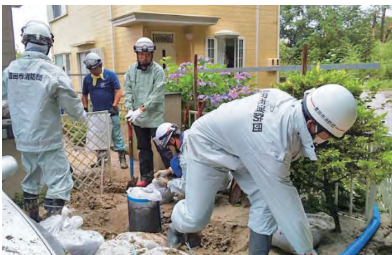
▲機械では作業できない土砂を撤去する消防団員
