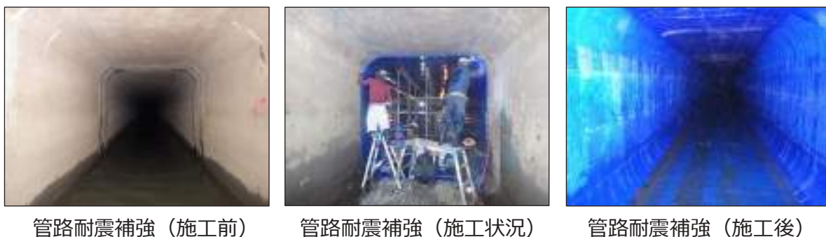
図 5-15 下水道管路の耐震化の施工例
