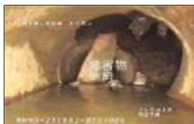
図3-7 下水道管路の破損例 (出典：国土交通省)
