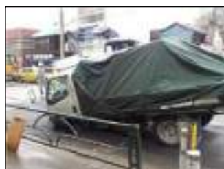
図3-6 下水道管路に起因した道路陥没事故例 (出典：国土交通省)
