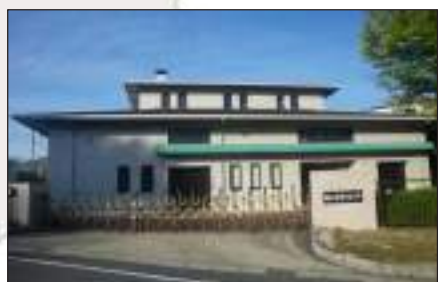
鞍ヶ池浄化センター
