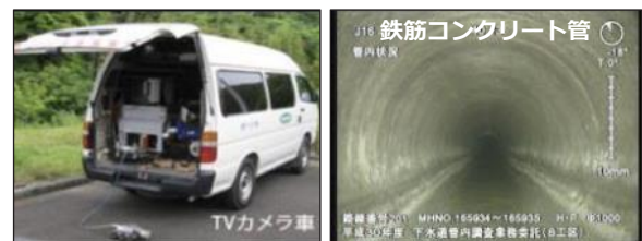
下水道管路の点検・調査
