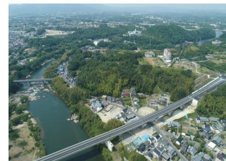
平戸大橋の整備
