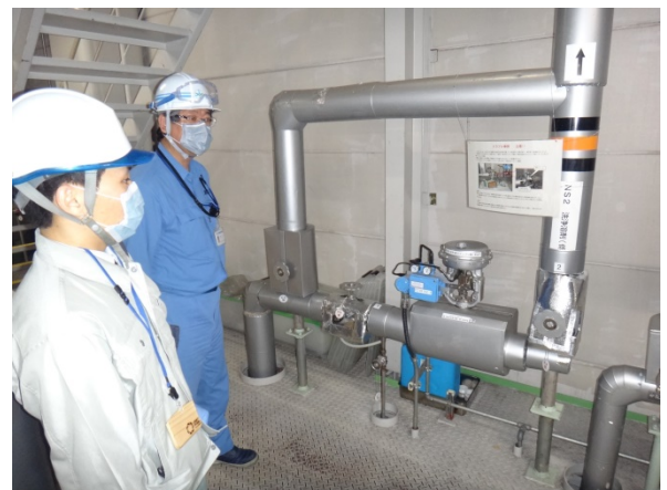
【2019.4.24 運転状況の確認】
