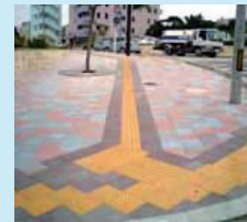
点字ブロック
