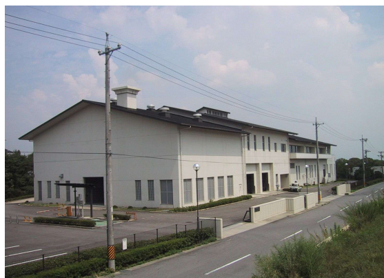
砂川衛生プラント
