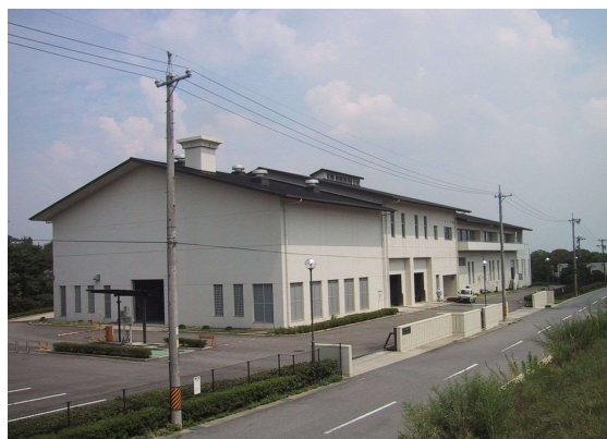
砂川衛生プラント
