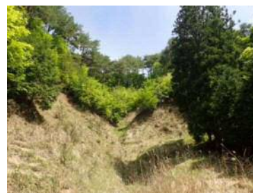
<急傾斜地の表層崩壊跡地 稲武地区の0次谷>
