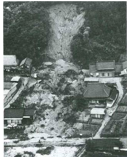
<47豪雨災害による裏山(旧藤岡村上川口付近)の崩壊>
