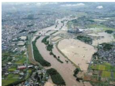
<浸水被害 直後の豊田市中心街>
