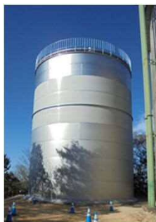
東山配水池の耐震化
