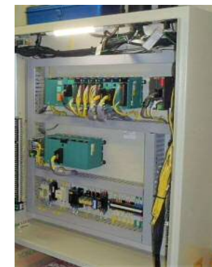
テレメータ盤の更新
