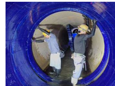
雨水幹線耐震補強工事 (3S工法)
