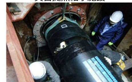
水道管の耐震化工事
