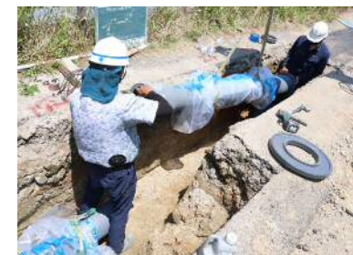
水道管整備工事
