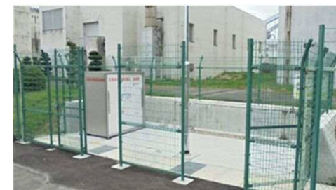
災害拠点給水施設
