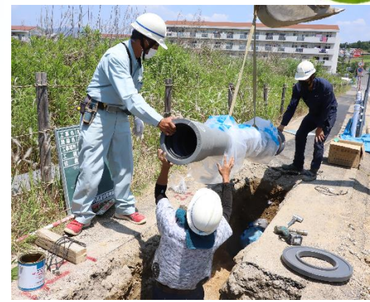
水道管整備工事
