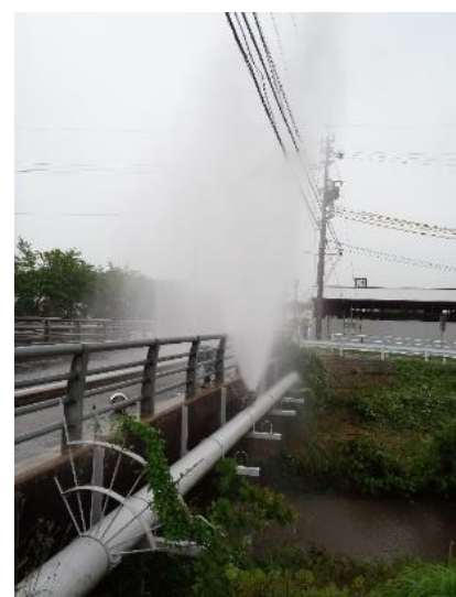
【貞宝町での漏水事故】
