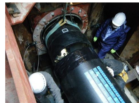
水道管の耐震化工事
