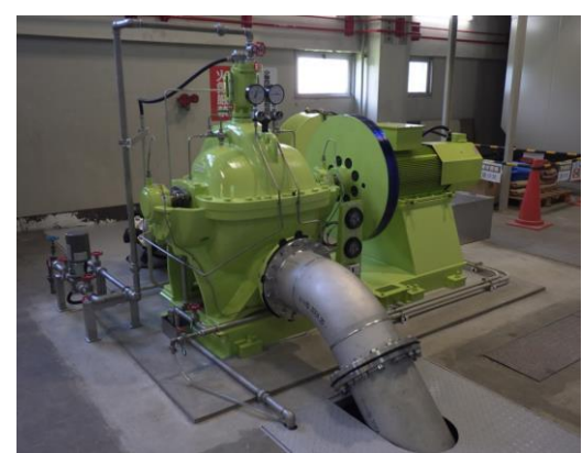
配水ポンプの更新
