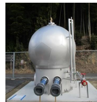
飲料用循環式耐震性貯水槽
