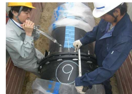
水道耐震管 埋設状況
