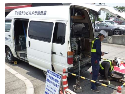
下水道管路TVカメラ調査
