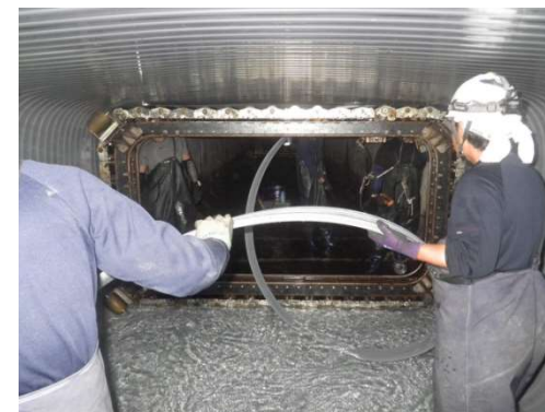
中部1号雨水幹線耐震補強工事 (SPR工法)
