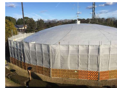
配水タンク防水工事
