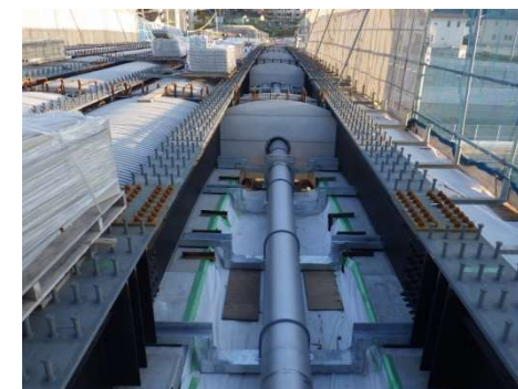
他事業に伴い 橋梁に水道管を添架
