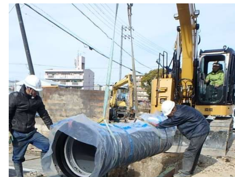
水道管整備工事
