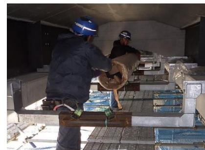
橋梁への水道管添架工事
