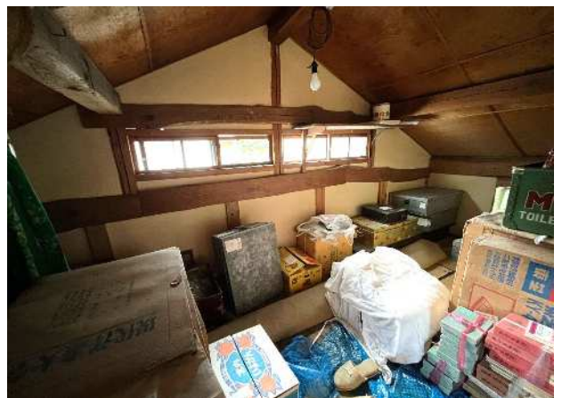
【2階 小屋裏物置】
