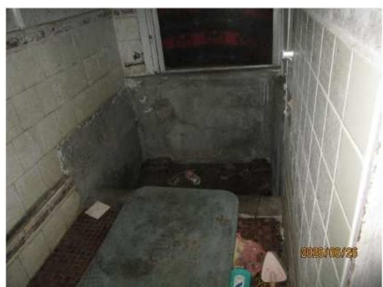
風呂 (浴槽無、床抜け有)
