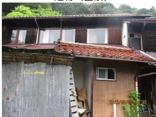
はなれ・便所（外観）
