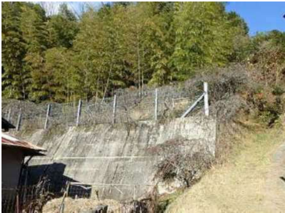
家の裏(治山擁壁)
