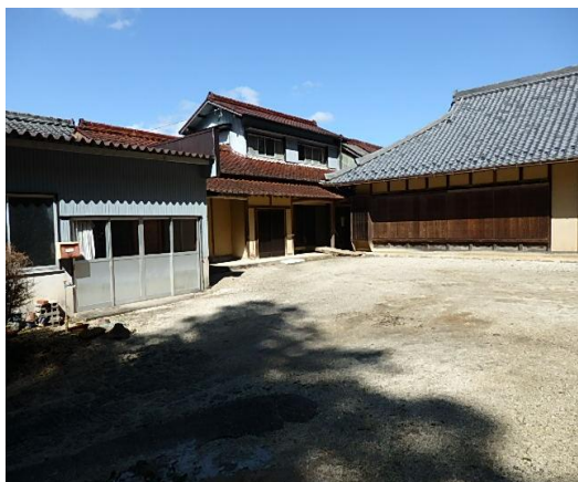
外観（工場、居宅、はなれ）
