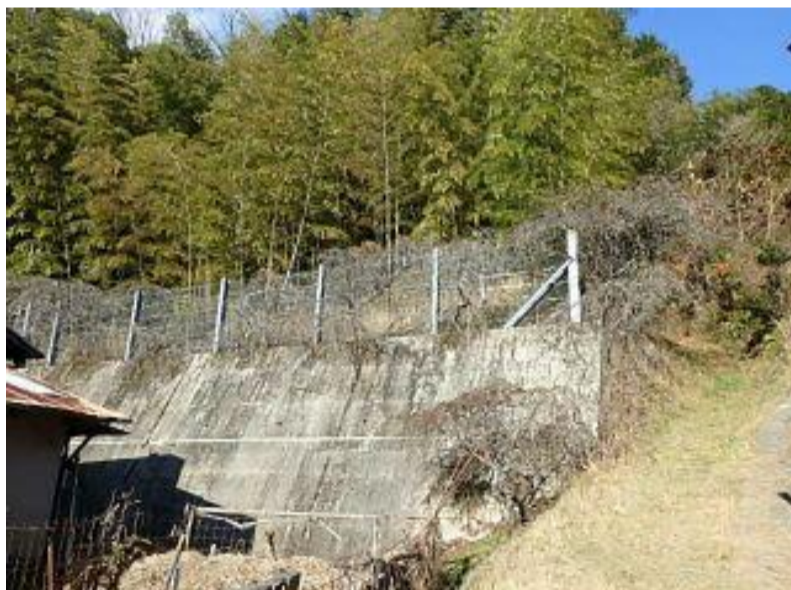
家の裏(治山擁壁)
