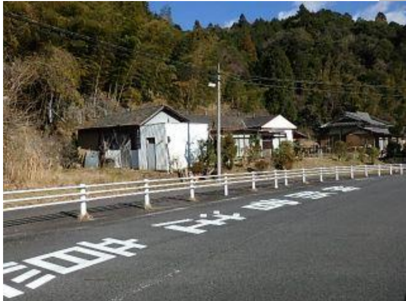
外観 上手から
