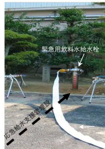
A13-002 : 応急給水支援設備整備 (空気弁 BOX の改造、 応急給水支援管の埋設、緊急用飲料水給水栓の設置)
