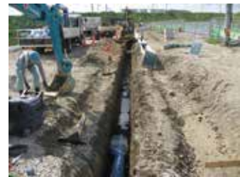
水道管布設の様子
