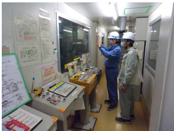
【H30.6.29 施設立上げ状況の確認】
