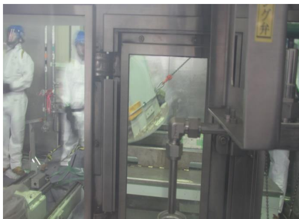
【H30.5.31 運転状況の確認】
