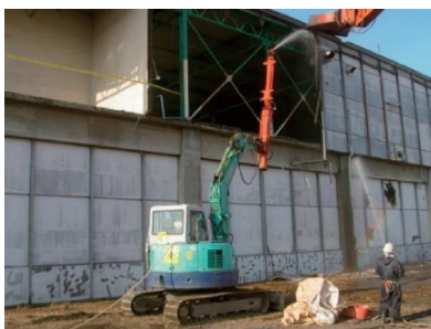
湿潤化の例(散水)
