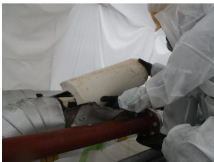
作業の状況 (養生内で湿潤化後手作業で除去)
