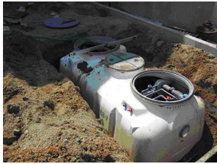
合併処理浄化槽の設置工事
