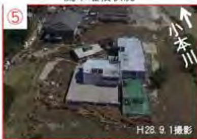
流木堆積状況
