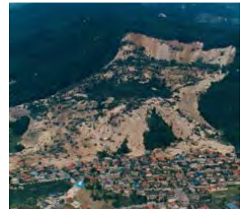
長野県長野市 地附山 (写真:長野県提供) (S60地附山地滑り災害)
