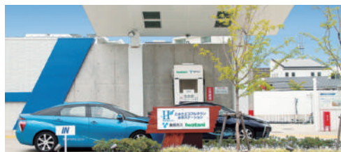
とよたエコフルタウン水素ステーション
