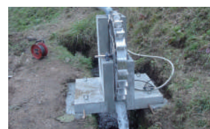
豊田市大野瀬町梨野集落(旧稲武地区)での水車(製作中)
