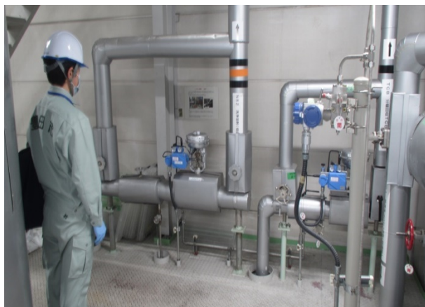
【H30.1.9 運転状況の確認】
