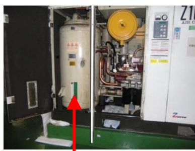
写真① レシーバタンク
