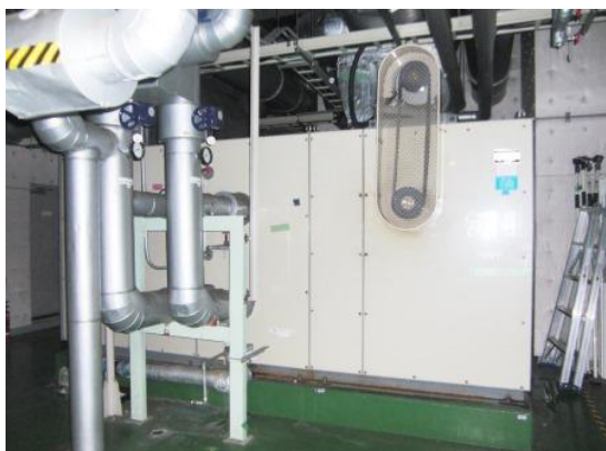
第一外調機の外観
