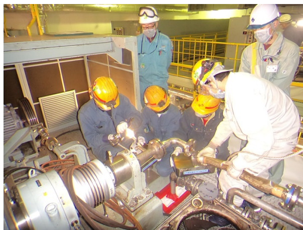
【H29.12.11 定期点検実施状況の確認】
