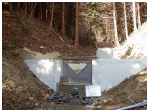
<水源かん養機能調査地（大洞市有林）>
