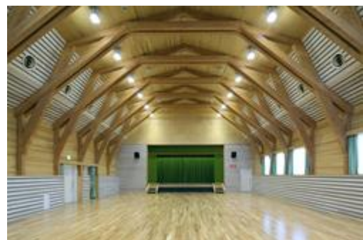
<木造公共施設(前林交流館)>
