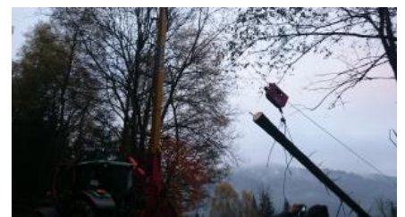
<タワーヤードによる集材>
