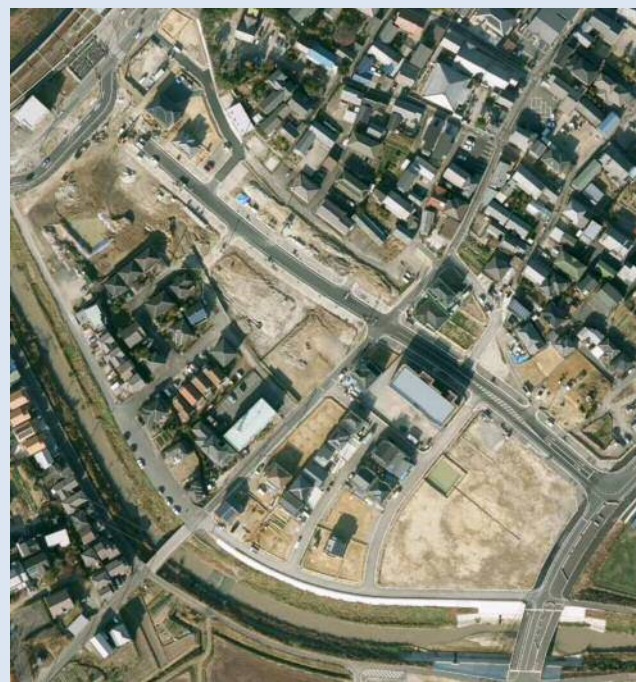
整備後（施行中）
