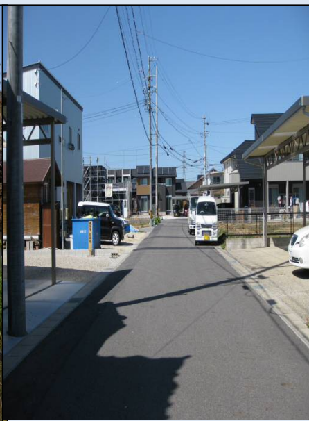
整備後 (施行中)
