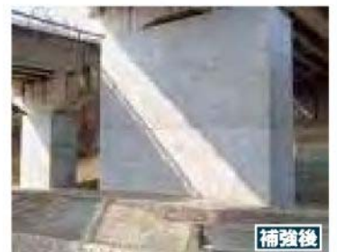
橋脚耐震補強(事例)
