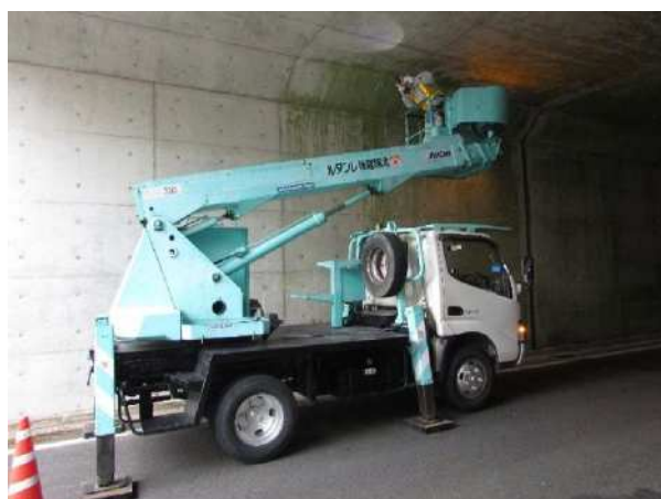
写真-6.6.1 大型カルバートの点検状況
