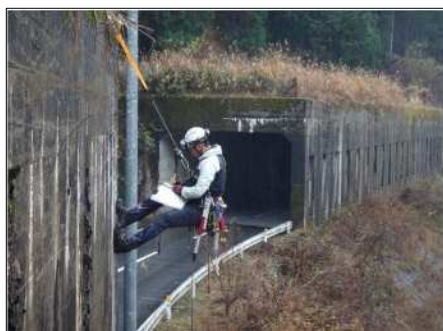
写真 6.5.1 シェッドの点検状況
