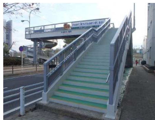
写真-6.3.4 修繕後 (主桁の塗替塗装を実施)
