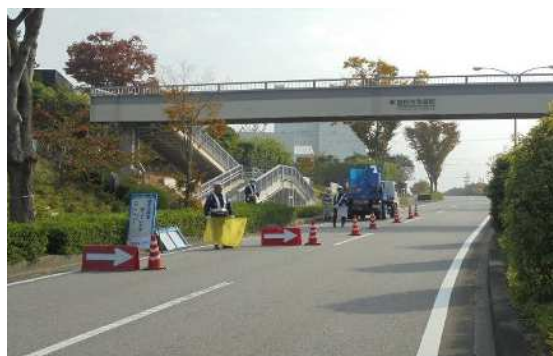
写真-6.3.2 道路の規制状況
