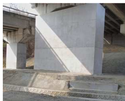
写真-6.2.6 橋脚耐震補強後
