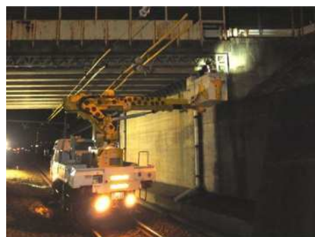
写真-6.2.2 桁下の点検状況
