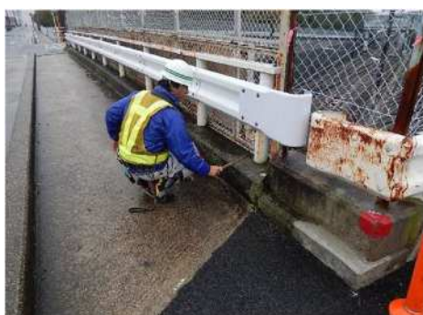
写真-6.2.1 路面の点検状況
