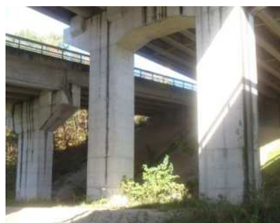
写真-6.2.5 橋脚耐震補強前
