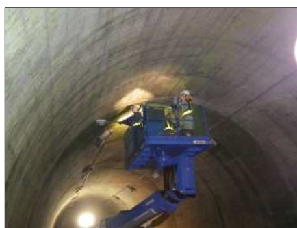
写真 6.4.1 トンネルの点検状況
