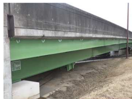
写真-6.2.4 修繕後 (主桁の塗替塗装を実施)
