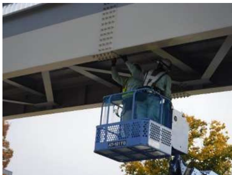
写真-6.3.1 桁下の点検状況
