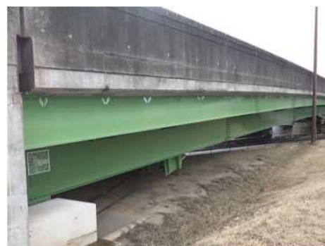
写真-6.2.4 修繕後 (主桁の塗替塗装を実施)
