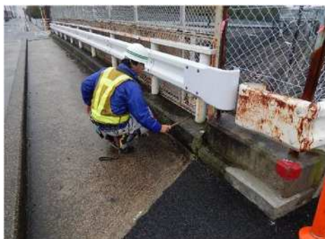
写真-6.2.1 路面の点検状況
