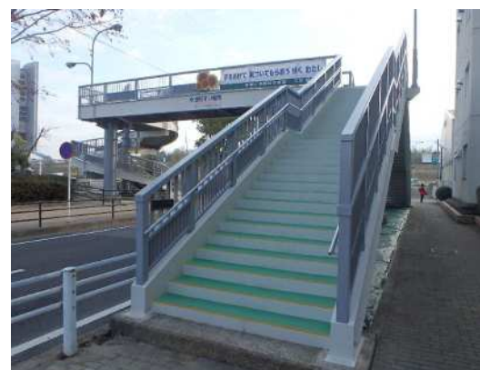
写真-6.3.4 修繕後 (主桁の塗替塗装を実施)
