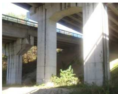
写真-6.2.5 橋脚耐震補強前
