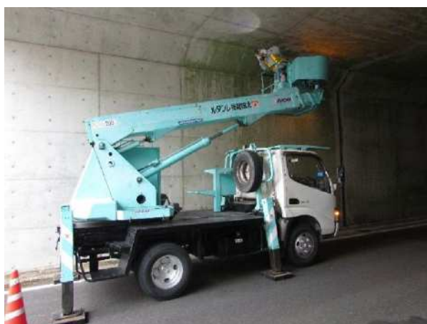
写真-6.6.1 大型カルバートの点検状況
