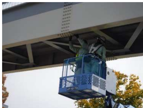
写真-6.3.1 桁下の点検状況
