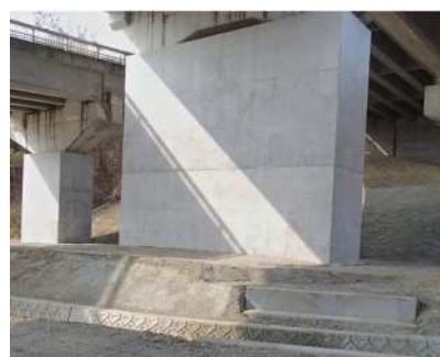
写真-6.2.6 橋脚耐震補強後
