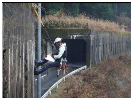
写真 6.5.1 シェッドの点検状況
