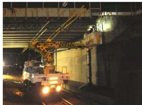
写真-6.2.2 桁下の点検状況
