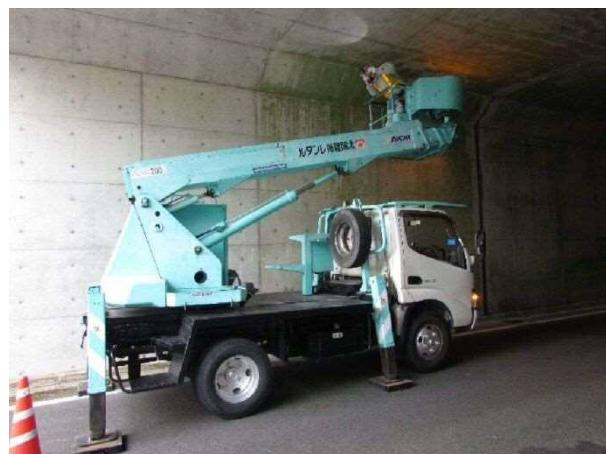
写真-6.6.1 大型カルバートの点検状況
