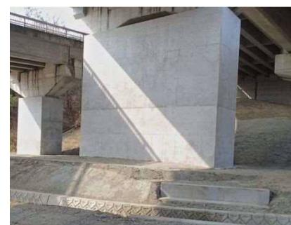
写真-6.2.6 橋脚耐震補強後
