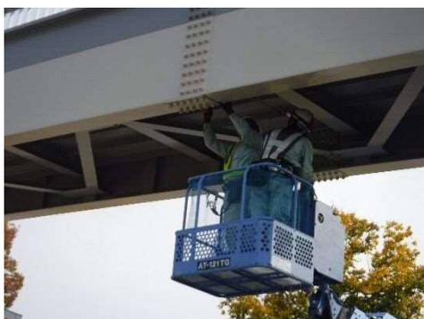
写真-6.3.1 桁下の点検状況
