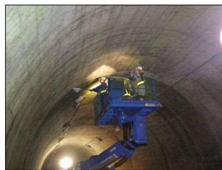
写真 6.4.1 トンネルの点検状況
