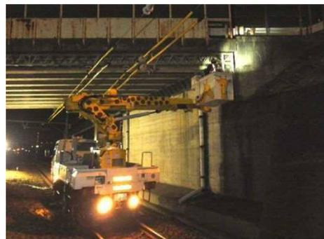
写真-6.2.2 桁下の点検状況
