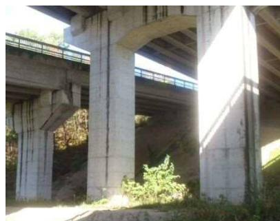
写真-6.2.5 橋脚耐震補強前
