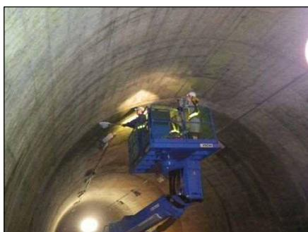
写真 6.4.1 トンネルの点検状況
