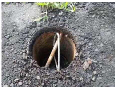
写真-6.8.1 照明柱基部腐食状況
