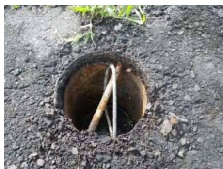
写真-6.8.1 照明柱基部腐食状況
