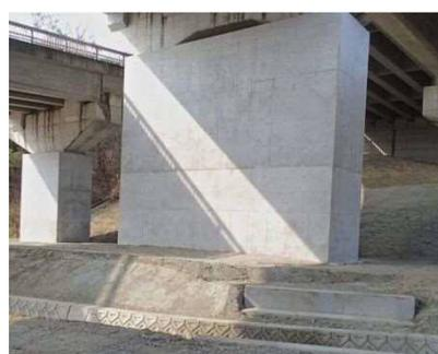
写真-6.2.6 橋脚耐震補強後
