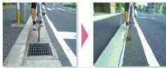
▲車道端部の構造を自転車走行に配慮し改良した案 〔出典〕東京建設局新技術情報データベース
