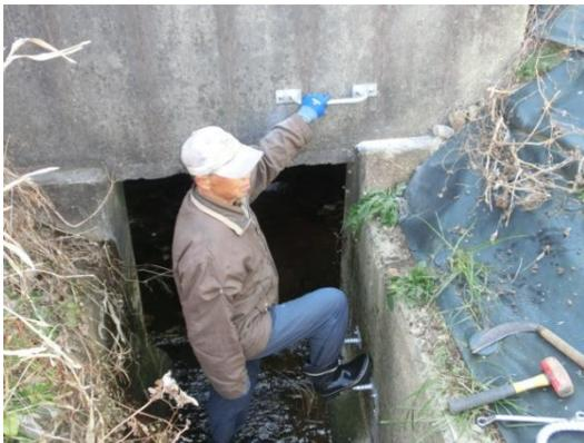
事故の再発防止に昇降用ステップを取付け
