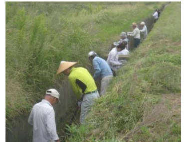
排水路の清掃
