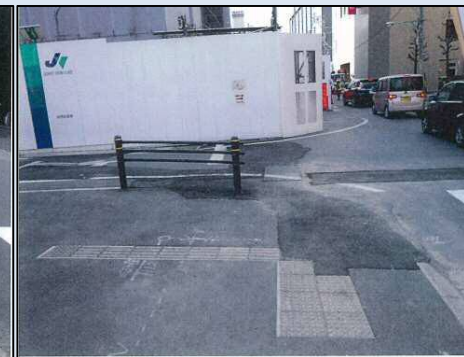
整備後 (施行中)
