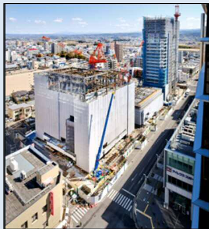
整備後 (施行中)
