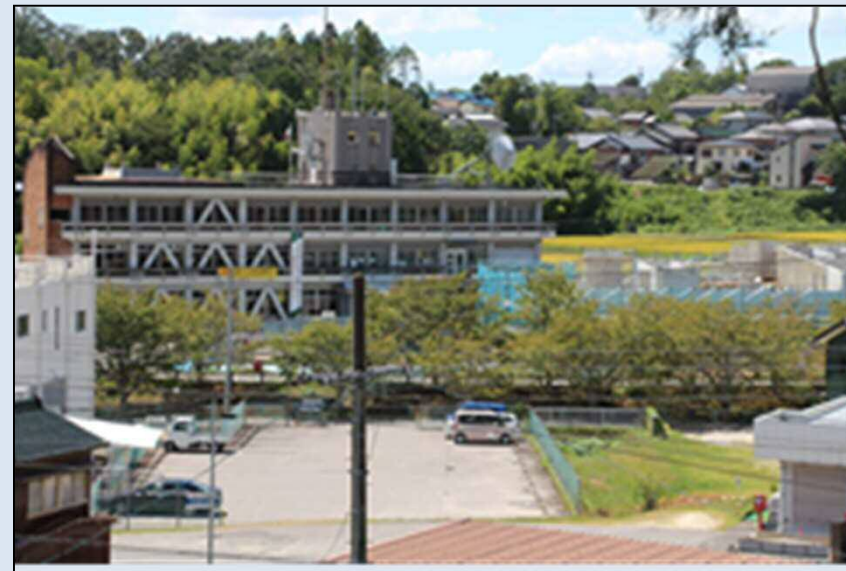
整備後 (施行中)
