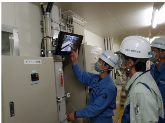
【①H27. 9. 29 大型コンデンサ解体設備の確認】
