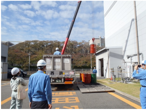
【③H27. 10. 27 高濃度運転廃棄物の搬出の確認】
