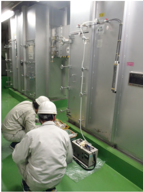
【H27.2.24 排ガス測定（活性炭処理後）】
