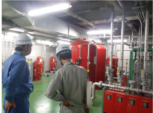
【H27.4.7 消火薬剤室の確認】
