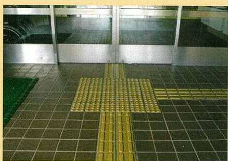
規定に沿った視覚障がい者誘導用ブロックの設置に努めます
