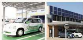
太陽光発電やEV充電施設を併設した工場
