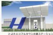
とよたエコプラタウン水素ステーション
