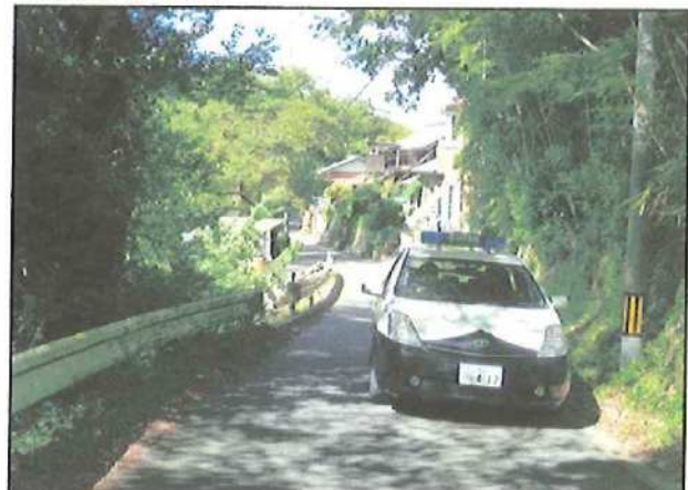
「長沢滝脇小学校線」 道路幅員 3.5m
