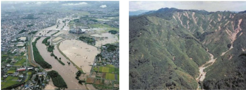
図 4-22 (左) 東海豪雨直後の豊田市中心部、(右) 土石流と表層崩壊
