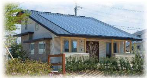
①住宅用太陽光パネル（例）
