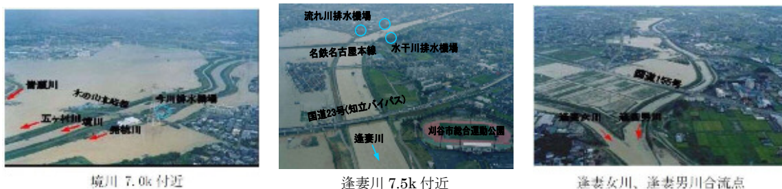
図 1.6 平成12年9月洪水被害状況
