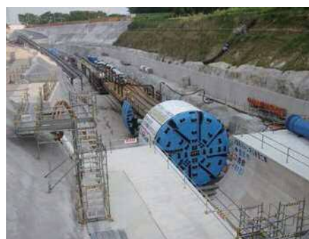
安永川の改修事業（トンネル工事）
