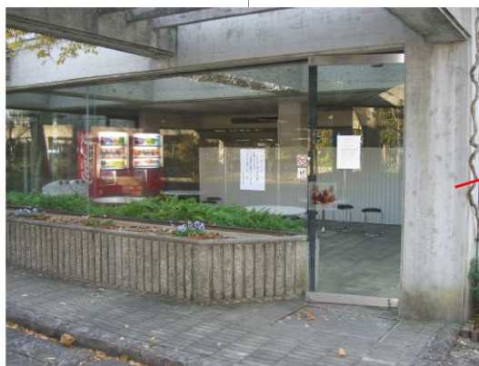
空店舗となった県緑化センター売店
