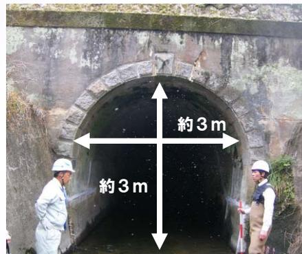
現況流下能力  $Q=10\text{m}^3/\text{s}$ 程度
